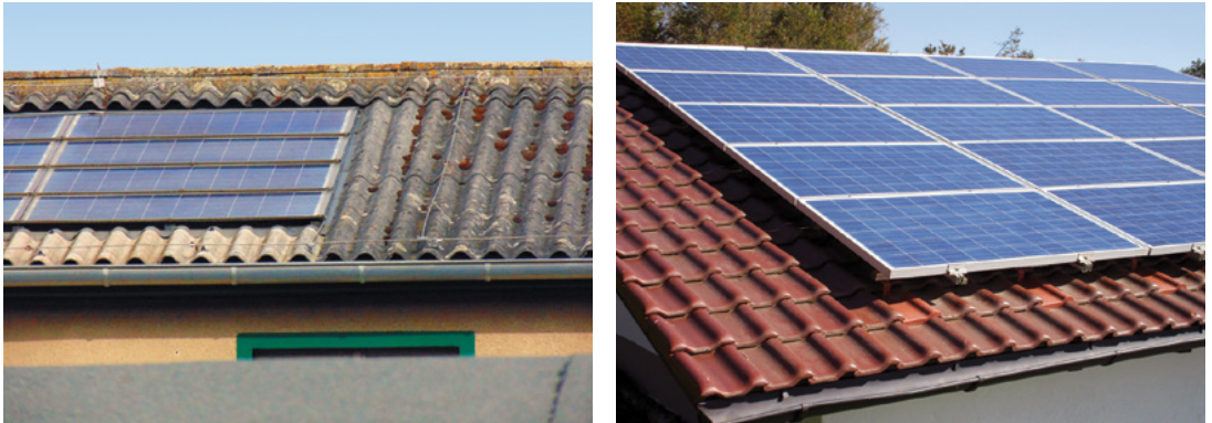
Abb. 3.5: PV-Module bei geneigten Dächern. Links: Indach-Montage. Rechts: Aufdach-Montage (Fotos: Alexander Maack, Bernd Demuth)
