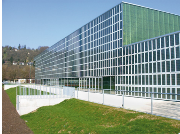
Abb. 3.7: PV-Fassadenanlage. Hierbei ersetzen die PV-Elemente die sonst üblichen Fassadenmaterialien aus z. B. Stein oder Glas (Foto: Kathrin Ammermann)
