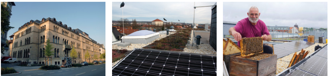
Abb. 3.2: Haus der Heyge-Stiftung in Weimar. Ein gelungenes Beispiel für die Kombination von PV-Dachanlage und Dachbegrünung sowie der Aufstellung von zwei Bienenstöcken (Fotos: Heyge-Stiftung, Matthias Golle, Bernd Müller)
