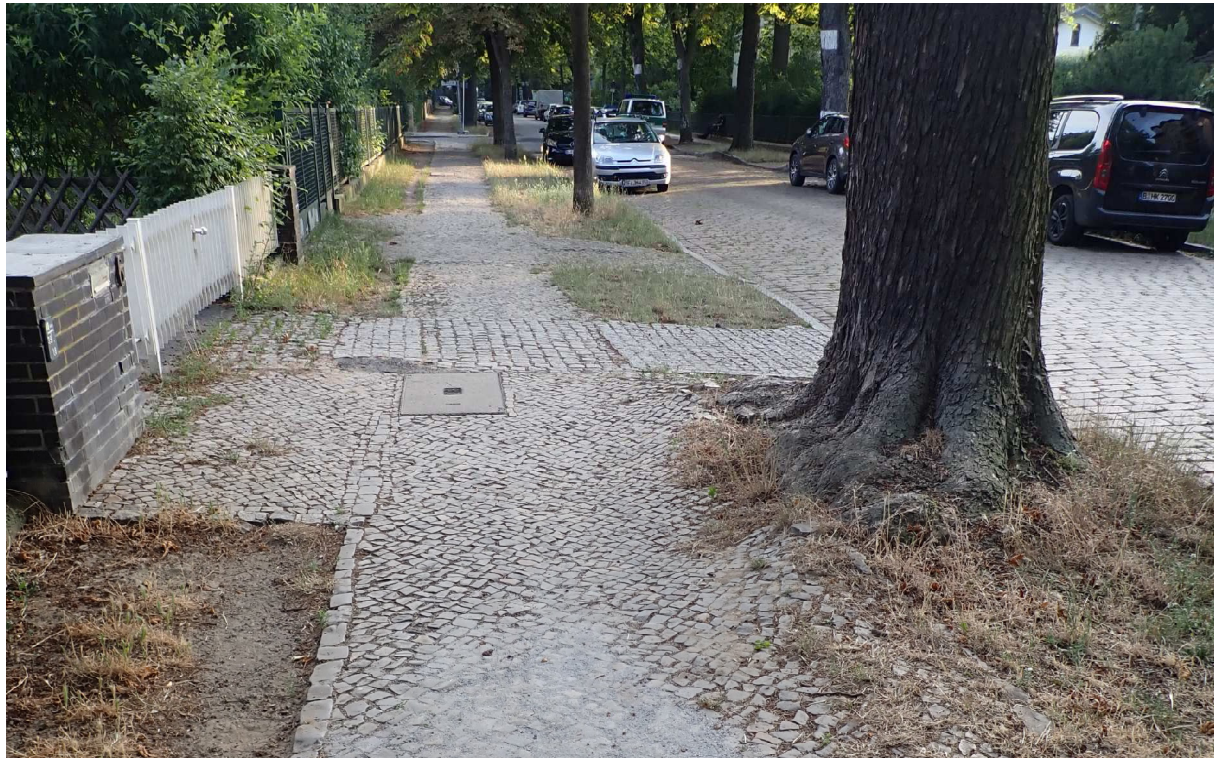
Abbildung 34: Gehweg mit Kleinpflaster in der Jägerstr. (eigene Aufnahme)
