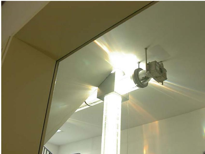
**Abb. 2:** Das Lichtrohrsystem im Treppenhaus mit der Schwefellampe
