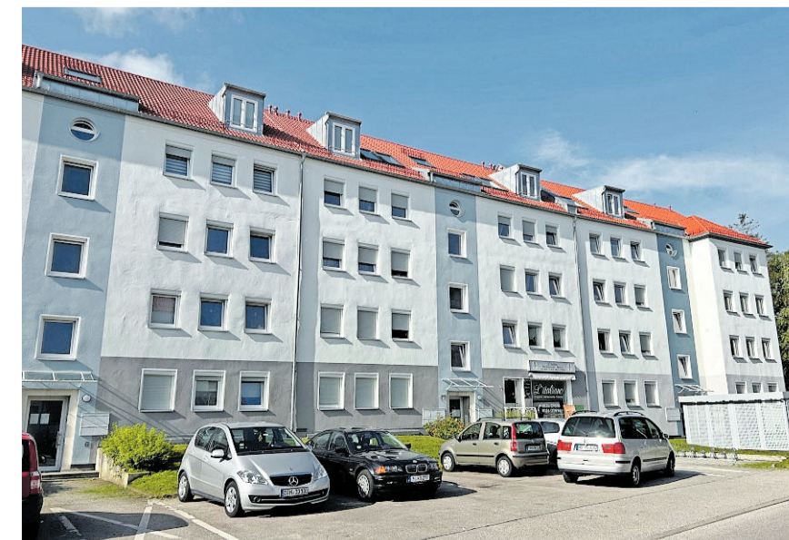
Rund um die Liegnitzer Straße hat der Immobilienkonzern 35 Gebäude aufgestockt und dadurch über 60 neue Wohnungen geschaffen. FOTO: VONOVIA
